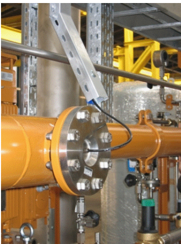
Abb.2 - 4 Sensor mit Flansch in der Rohrleitung installiert
