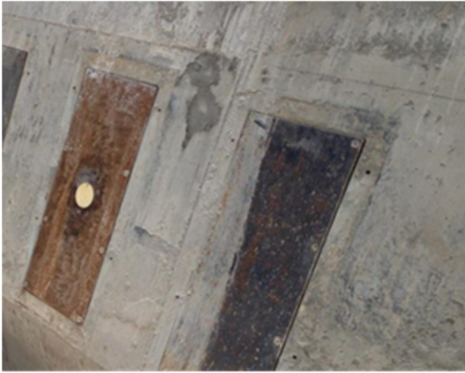
Abb.1 Sensor Einbau in Materialrutsche
