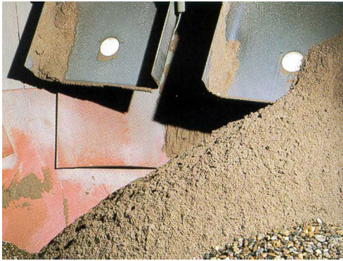
Abb. 1 Einbau in Rutsche
